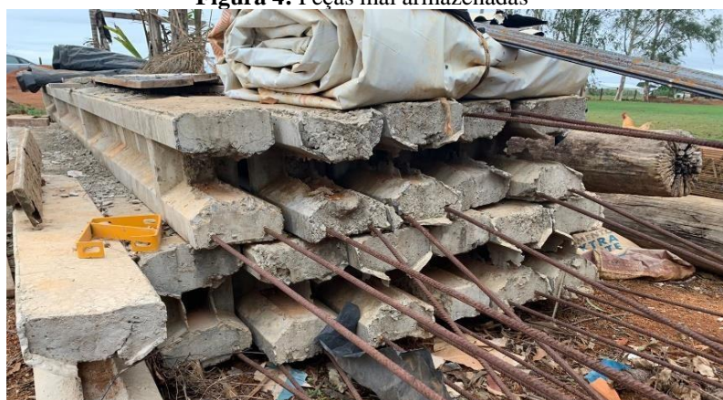
Figura 4: Peças mal armazenadas
