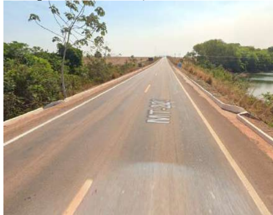
Figura 5: Drenos superficiais do KM 22.
