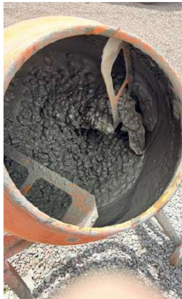
Figura 2: Betoneira com 17 litros de concreto rodando um traço
