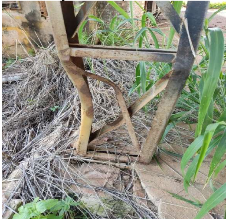
Figura 5: Deformações excessiva.
