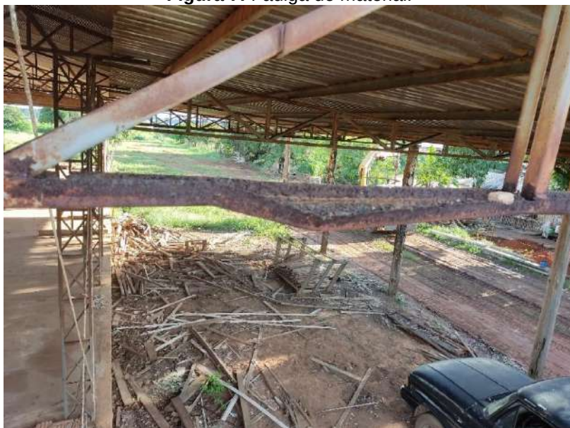
Figura 7: Fadiga do material.
