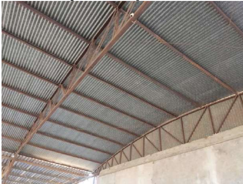
Figura 4: Corrosão generalizada.
