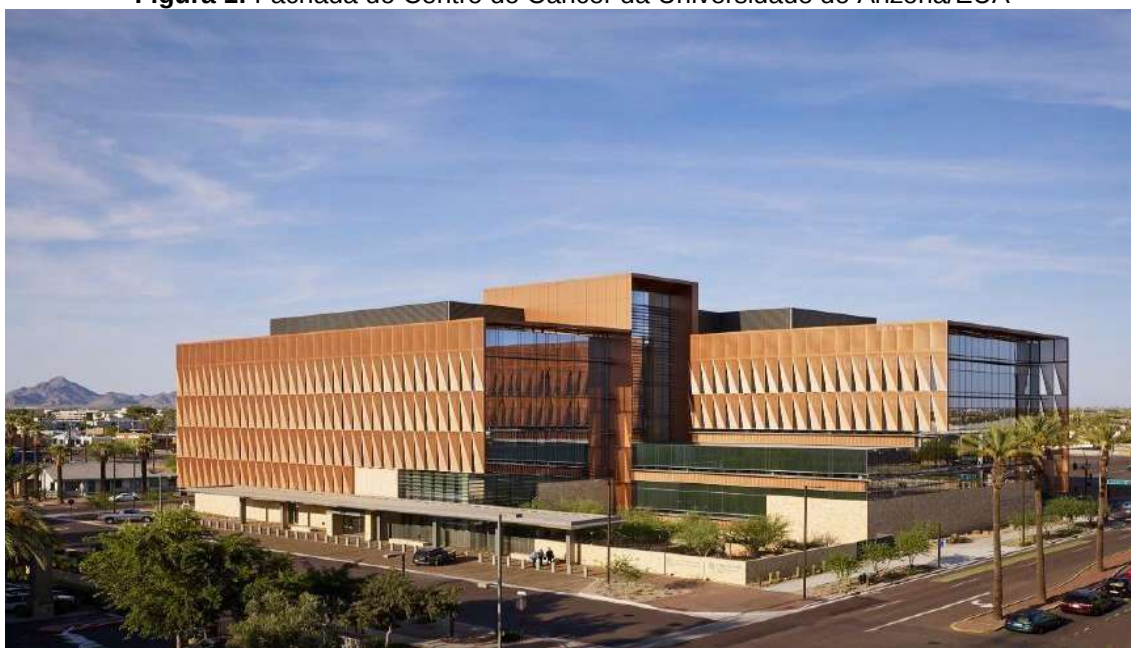
Figura 1: Fachada do Centro do Câncer da Universidade do Arizona/EUA
