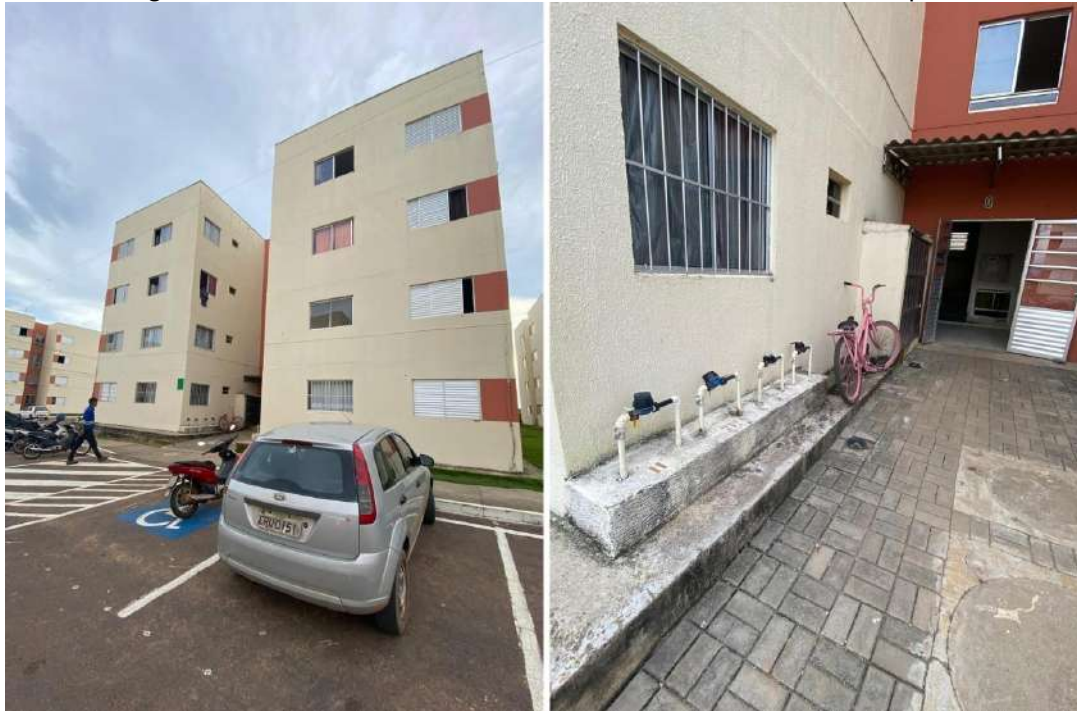
Figura 2: Fachada do Bloco “J” do Residencial Nico Baracat – Etapa 4.
