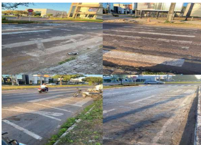
Figura 3: Sinalizações horizontais implantadas em campo
