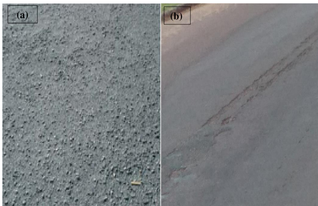
Figura 4: (a) Modelo de ocorrência de desgaste segundo Bernucci et. al (2008), (b) Manifestação patológica caracterizada como desgaste encontrada na avenida André A. Maggi.
