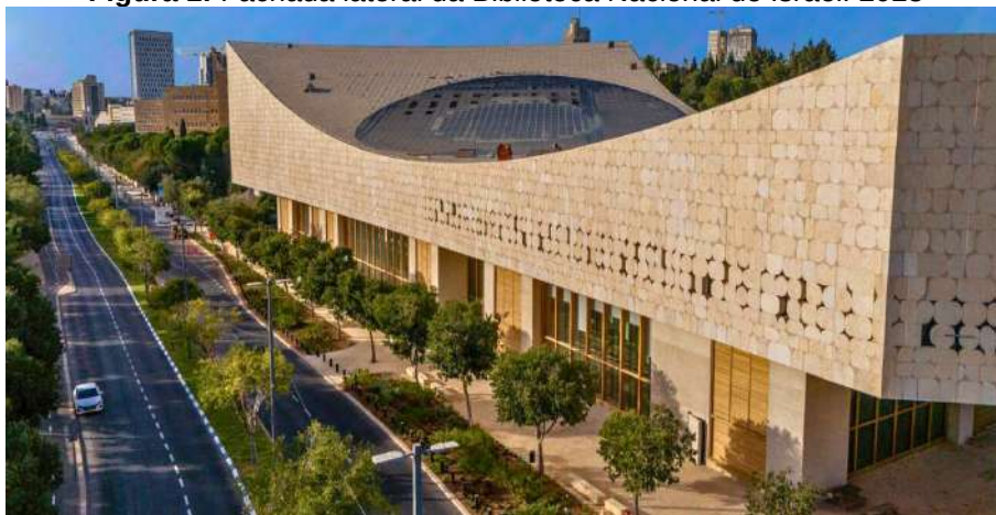
Figura 1: Fachada lateral da Biblioteca Nacional de Israel. 2023
