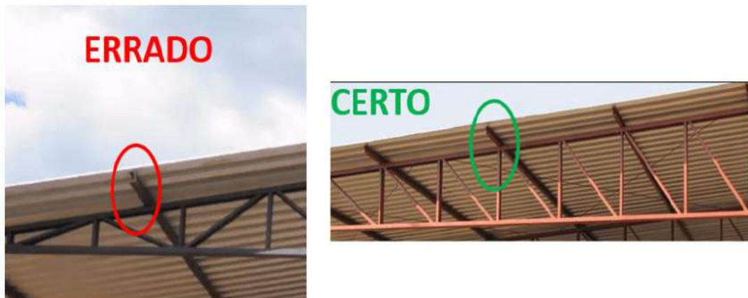
Figura 3: Terças apoiadas fora dos nós da treliça
