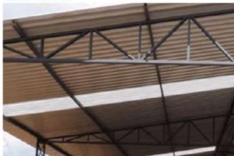
Figura 4: Ausência de contraventamento
